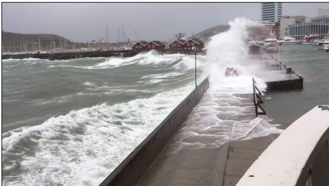
Figur 4-9: Døme på overskylling i Bodø under stormen Sally i 2020 (bølgetilstand H_s=1.4 m / T_p = 4.5 s). Molo ligg på kote +3 m (NN2000). Vasstand var 1.9 m. Gjennomsnittlig overskylling er estimert til 5 l/m/s basert på Van der Meer, et al. (2018).
