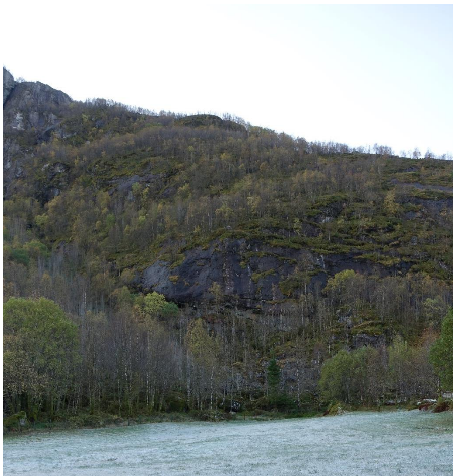
Figur 29 Glattskurt berg utan stor oppsprekking. Lite sannsyn for utfall.
