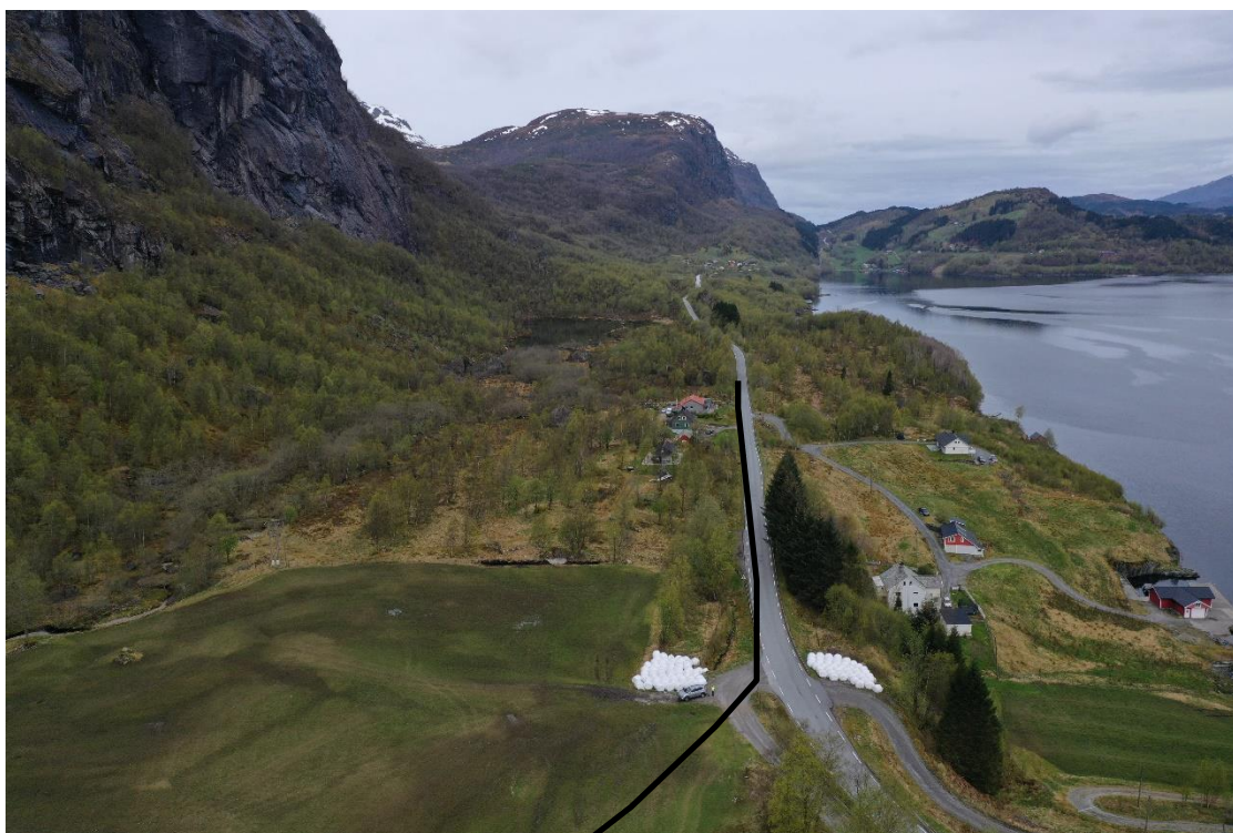
Figur 23 Bilete som viser veglinja frå tunnelen i Hestvika og vestover lang eksisterande veg.
