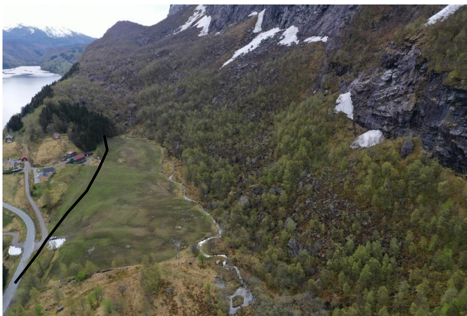
Figur 10 Dronebilde (Foto: Vestland fylkeskommune) som viser vegetasjonstilhøva i fjellsida over Hestvika.
