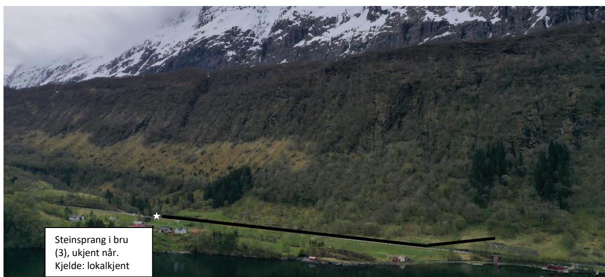
Figur 16 Dronebilde som viser plassering av kjende skred på strekningen til veglinje 14 000.
