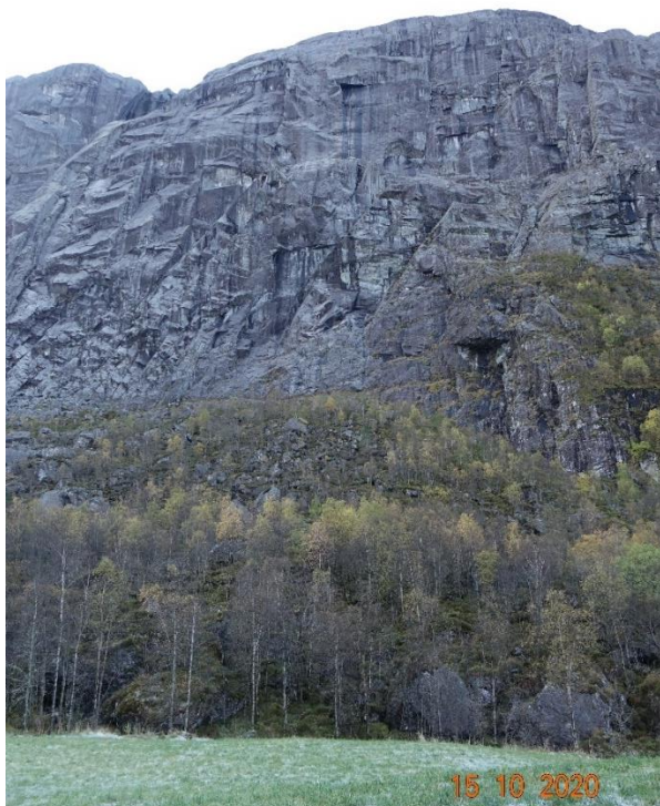
Figur 8 Fjellsida med relevans på skredfare mot tunnelpåhogget i Hestvika.
