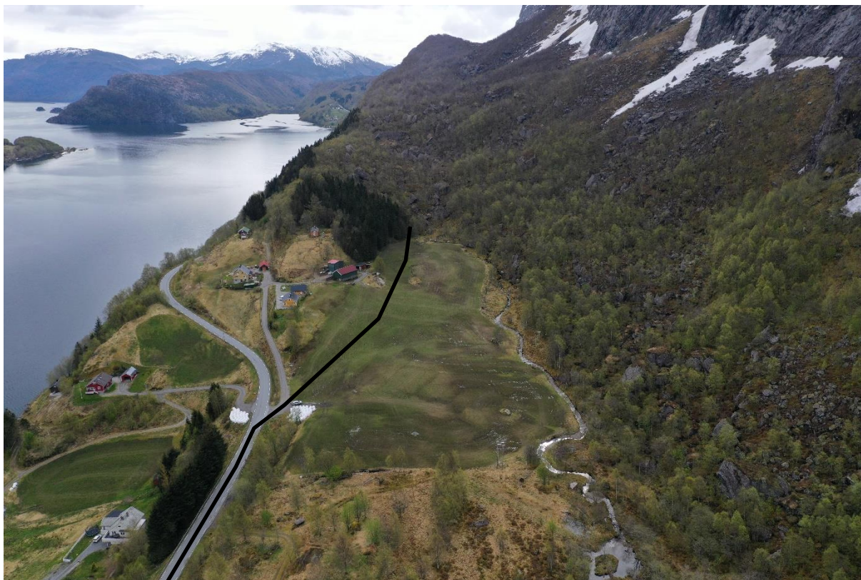
Figur 22 Bilete som viser terrenget ved tunnelportal og vestover i Hestvika.
