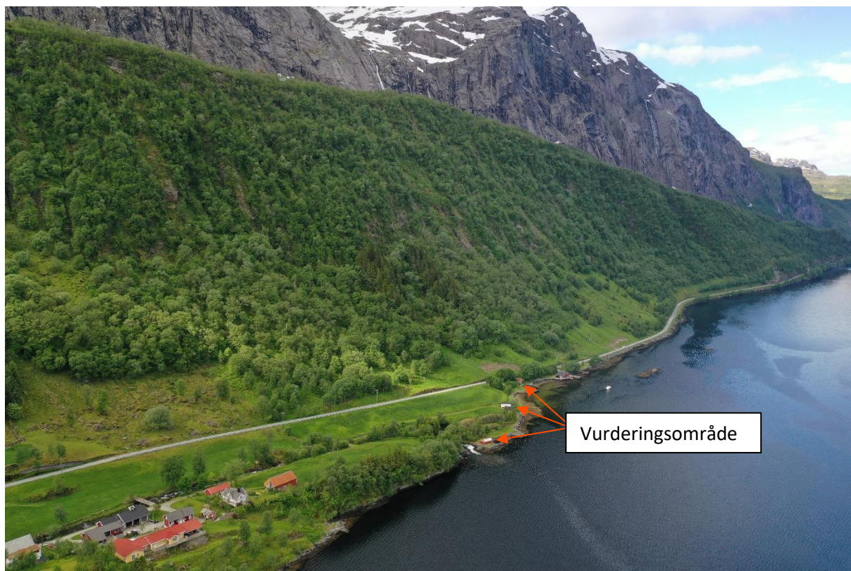
Figur 13 Dronefoto som viser fjellsida over nausta (markert med piler).
