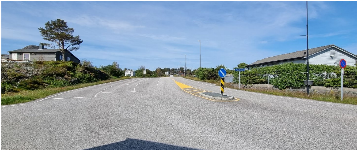
Figur 5-4 Dagens oppstillingsfelt og veg. Foto: VLFK.
