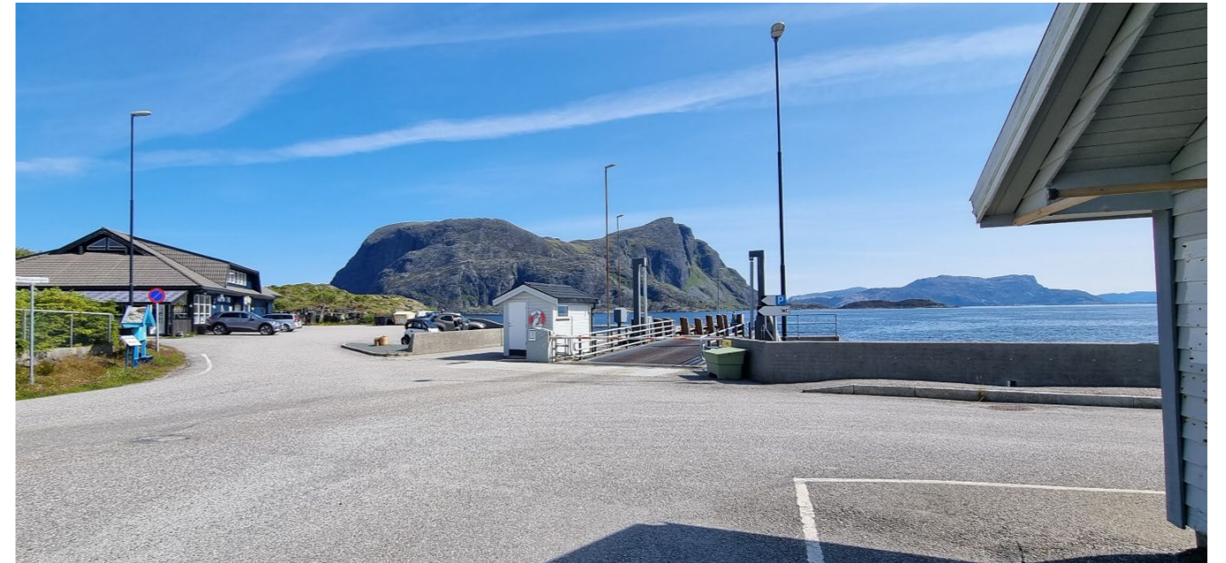
Figur 5-1 Dagens kai med ferjekaibru sett frå land. Foto: VLFK.
