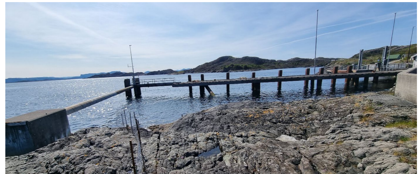
Figur 5-2 Dagens tilleggingskai sett frå svaberget ved daglegvarebutikken. Foto: VLFK.
