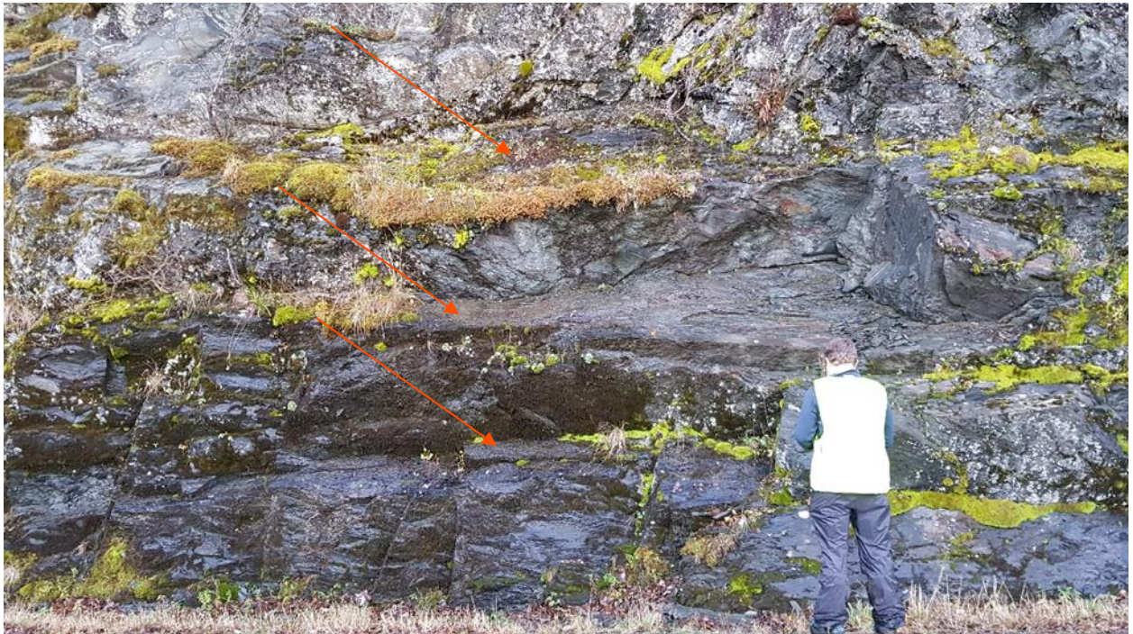
Figur 18: Dalsideparallelt sprekkesett (piler) med sprekkeavstand mellom 2-5 meter. Biletet er tatt mot sør i skjeringa langs eksisterande veg.
