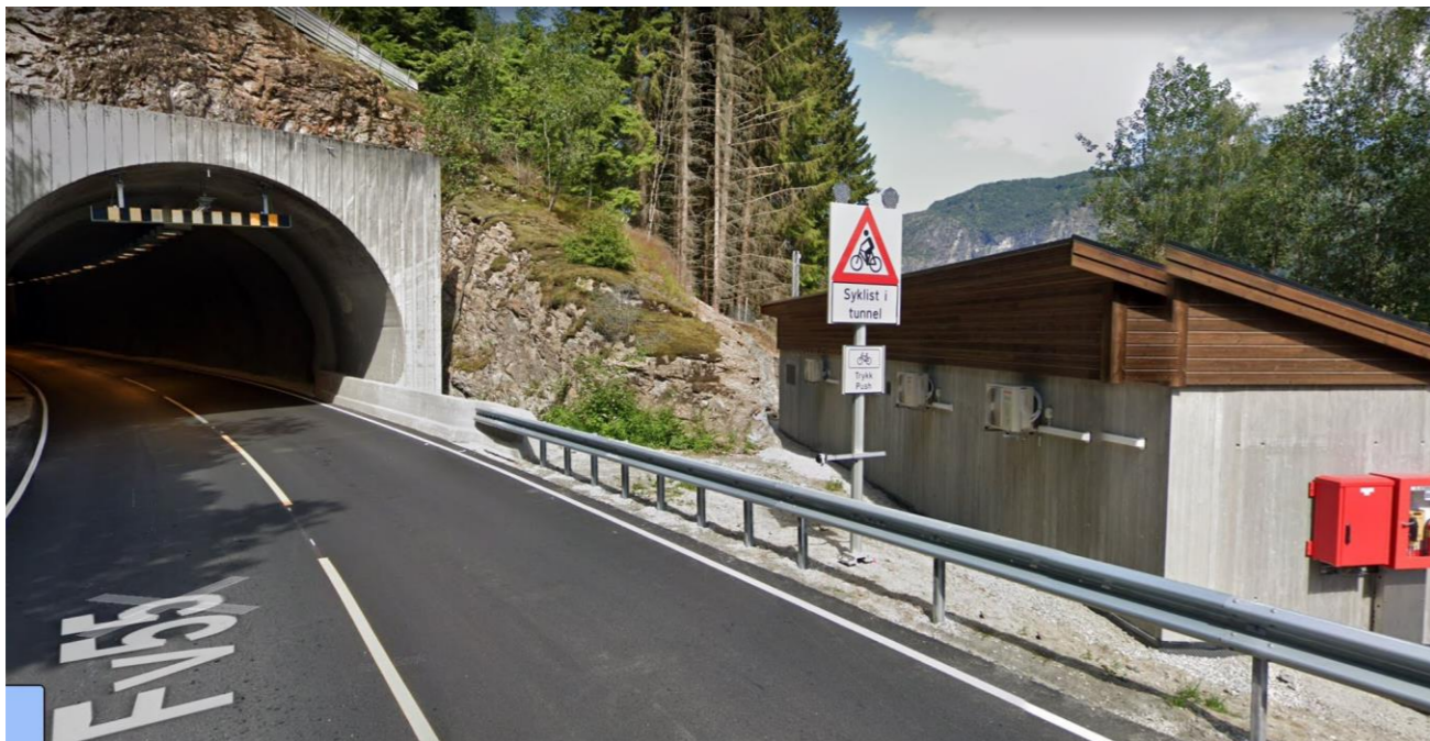
Figur 8-4: Blinkande varselskilt gjer bilistar oppmerksame på at det befinn seg syklistar i tunnelen. Utklipp frå Google Streetview. Fv.55 i Luster kommune.
