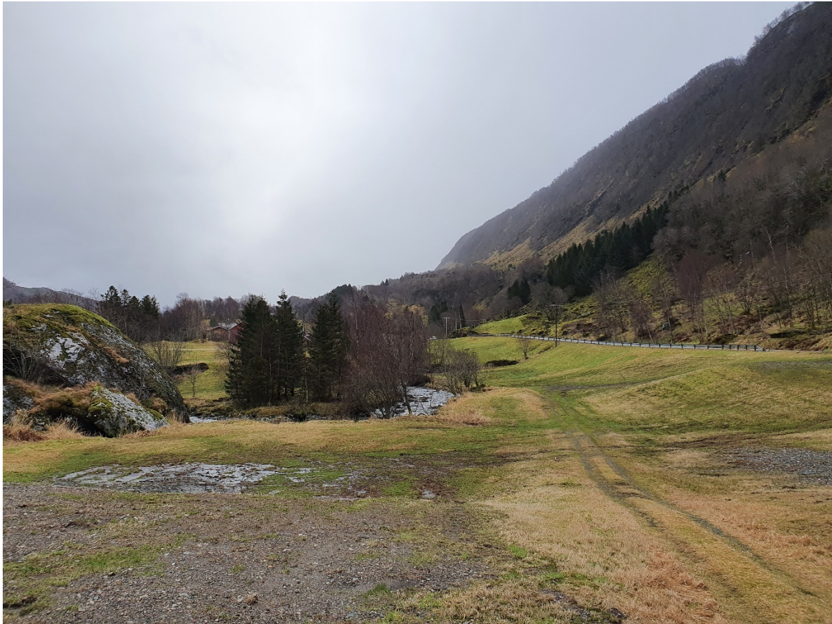
Figur 4: Fjell i dagen som avgrensar sone mot sjø mot nord. Skråning med utilstrekkelig stabilitet er mot vegen til høgre i bilde.
