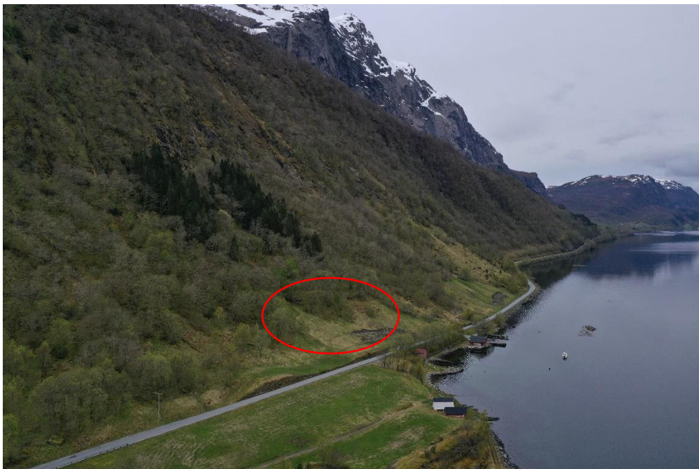
Figur 5: Bilde av område for forskjæring og påhogg. Markering for omtrentleg plassering av påhogg. Bilde tatt av Ingrid Hynne, Vestland fylkeskommune.
